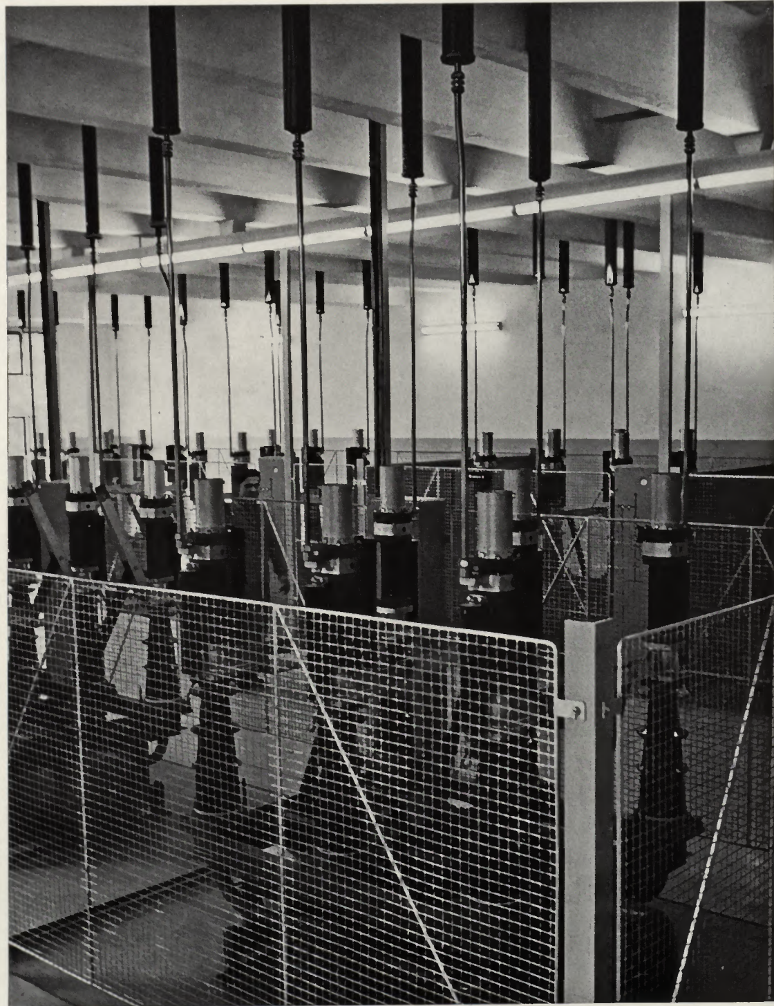
50 kV-Schaltanlage
