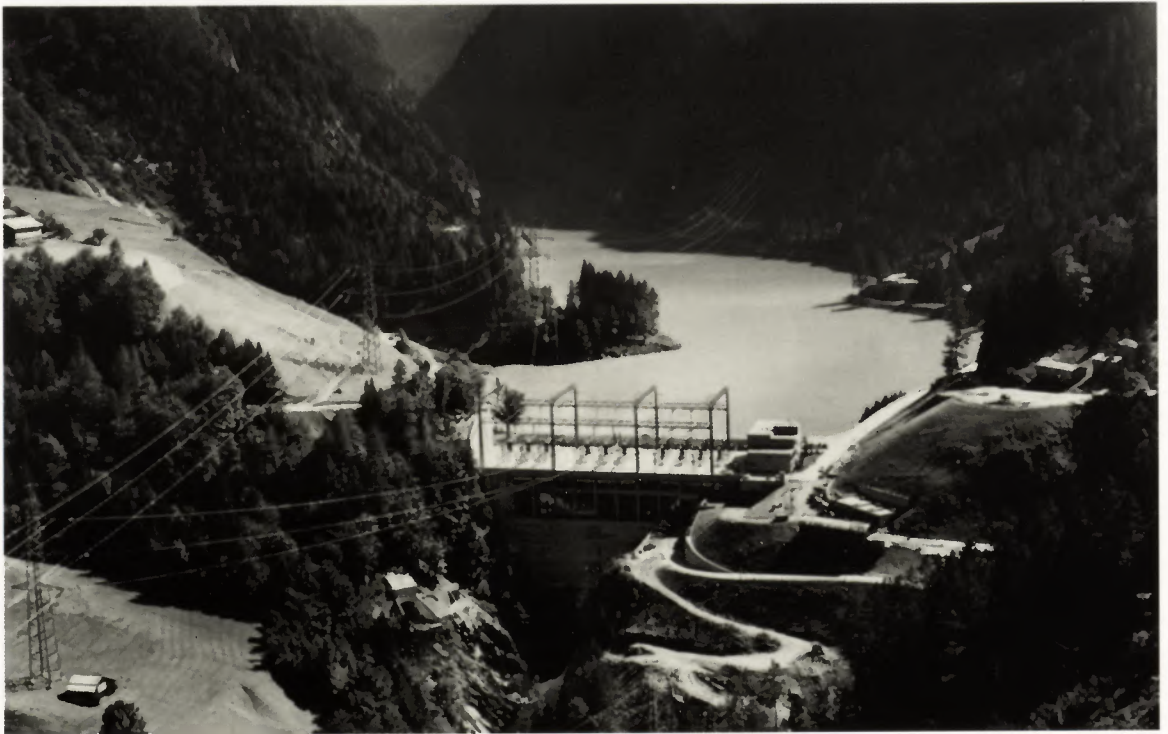
Kraftwerk Sarganserland, Zentrale Mapragg mit Ausgleichsbecken, 1977
