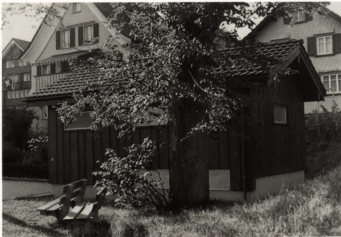
Transformatorstation in Gonten – Eingliederung der Ortsversorgung ins Ortsbild, 1985
