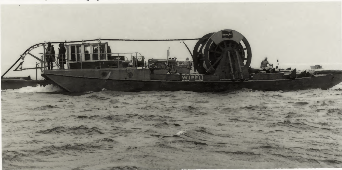
Muslenwerk, Seekabelverlegung nach Weesen, 1981
