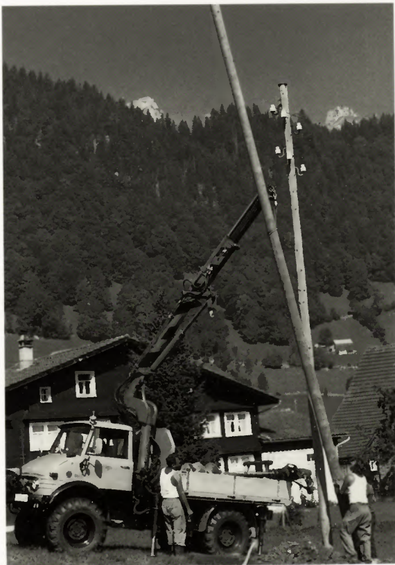
Einsatz mechanischer Hilfsmittel beim Leitungsbau, 1973
