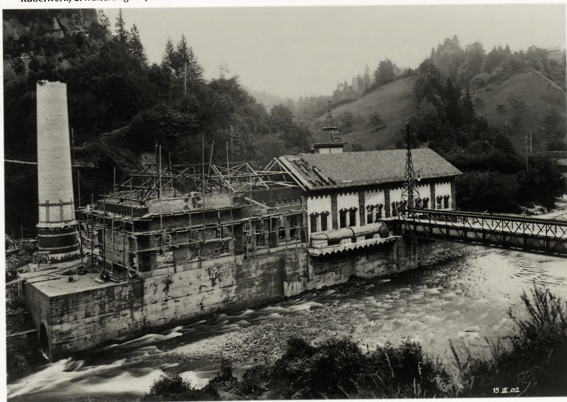
Kubelwerk, Erweiterung im Jahre 1902
