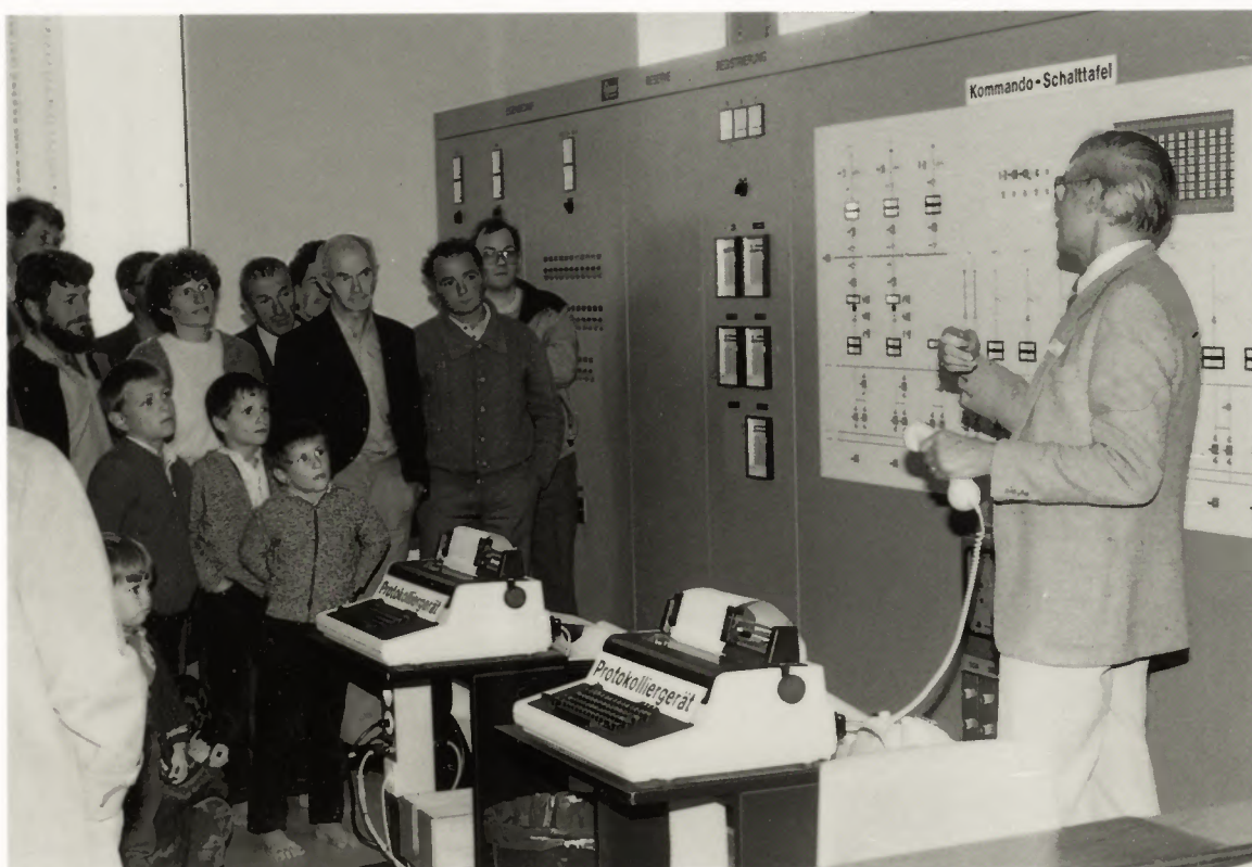
Sie interessieren sich für den Strom: Tag der offenen Tür im Unterwerk Appenzell am 22. September 1984
