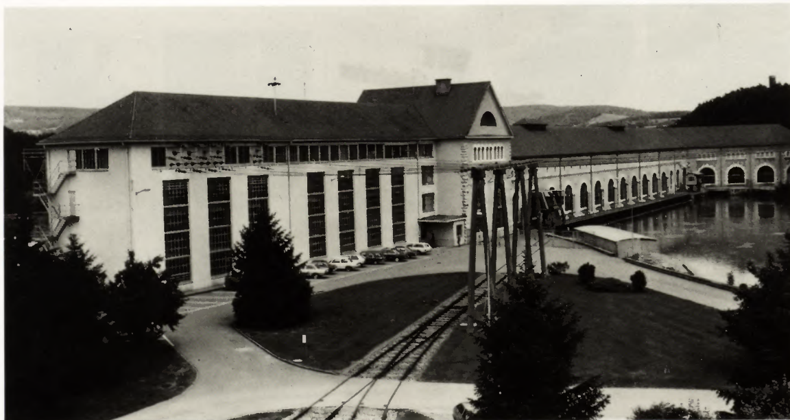
Niederdrucklaufwerk Beznau 1902, letzte Erneuerung 1932
