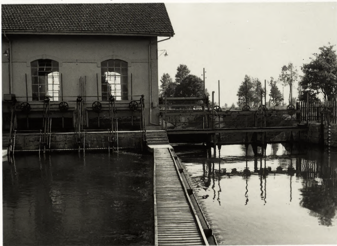
Binnenkanalwerke, Zentrale Montlingen 1963
