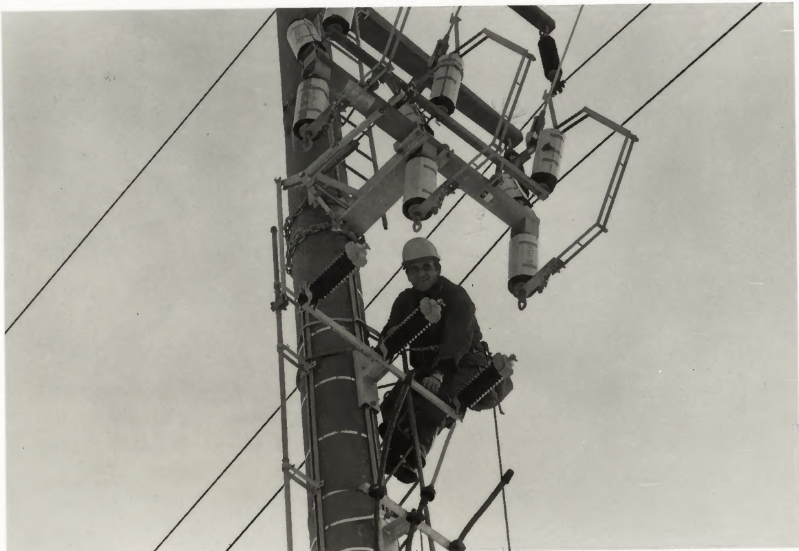
Handmontage auf dem Betonmast, 1984
