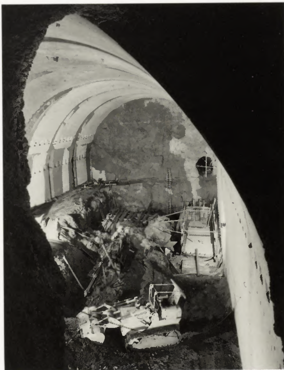
Kubelwerk, Ausbruch der Kaverne 1974 (in Bildmitte rechts Eintrittsöffnung des Druckstollens)
