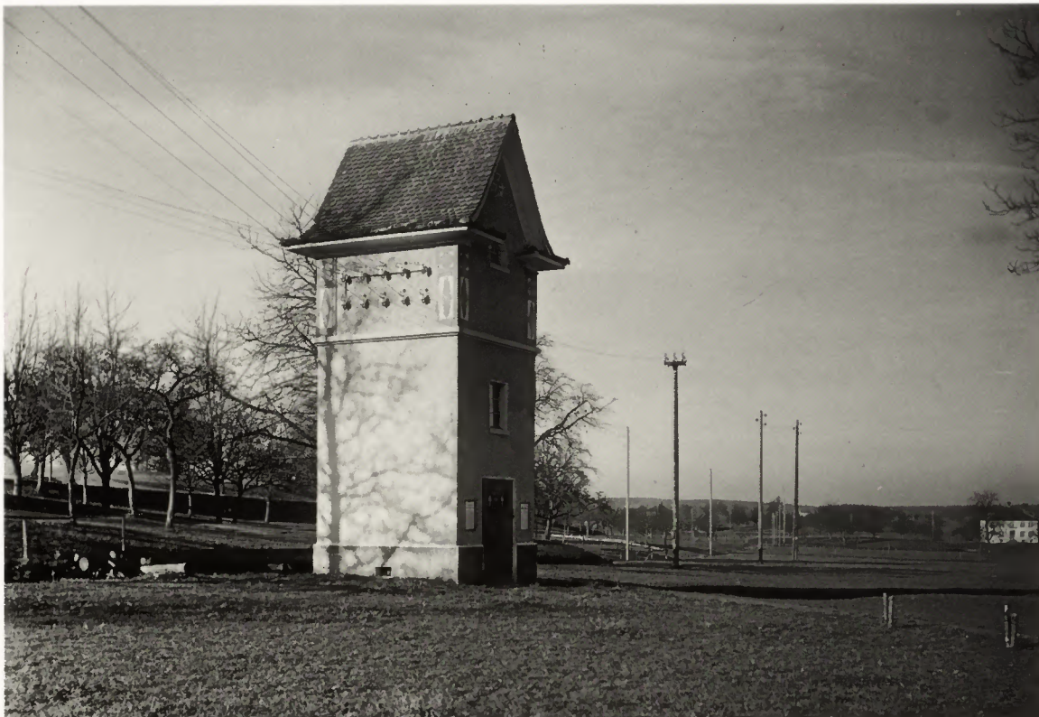
Transformatorstation aus dem Jahre 1914
