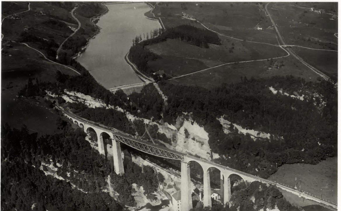
Kubelwerk, Gesamtansicht aus dem Jahre 1925
