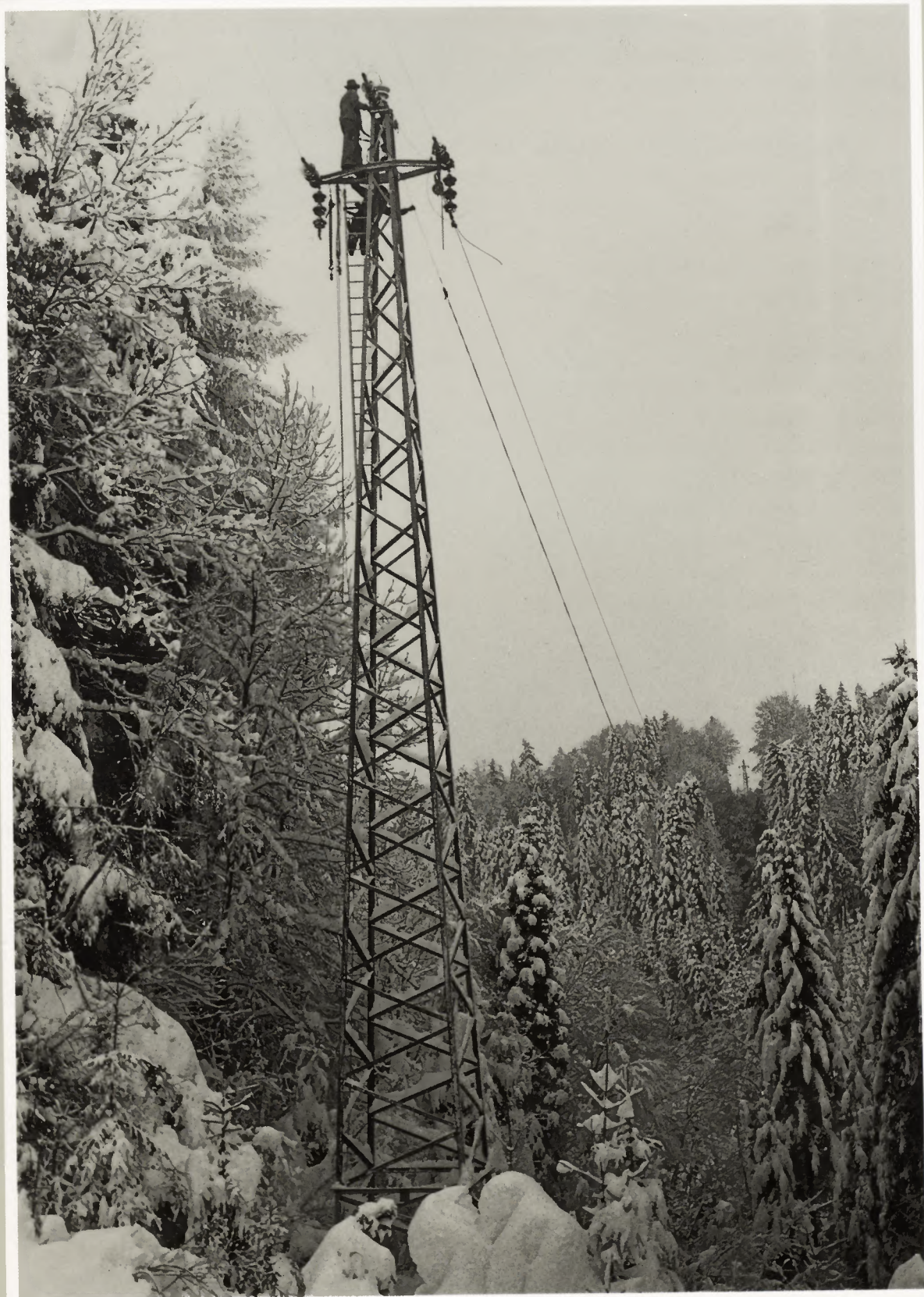
Leitungsreparatur im unwegsamen Gelände (1963)
