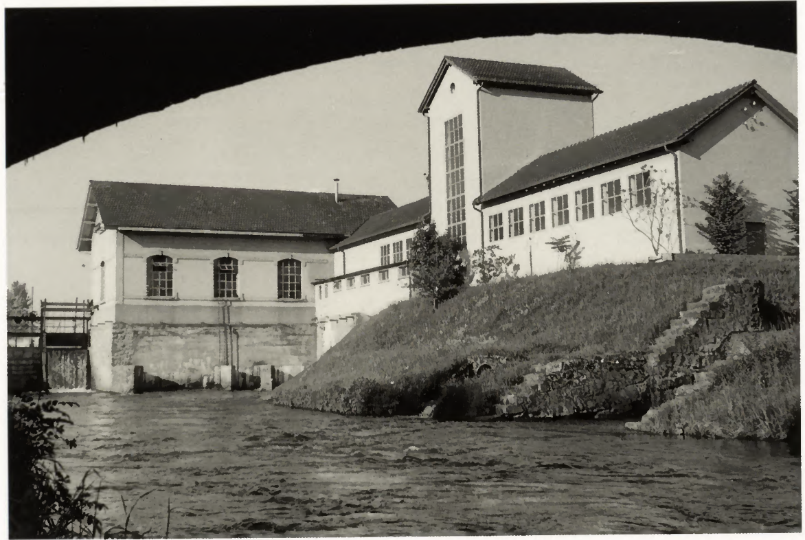
Unterwerk Montlingen mit Binnenkanalwerk, 1957
